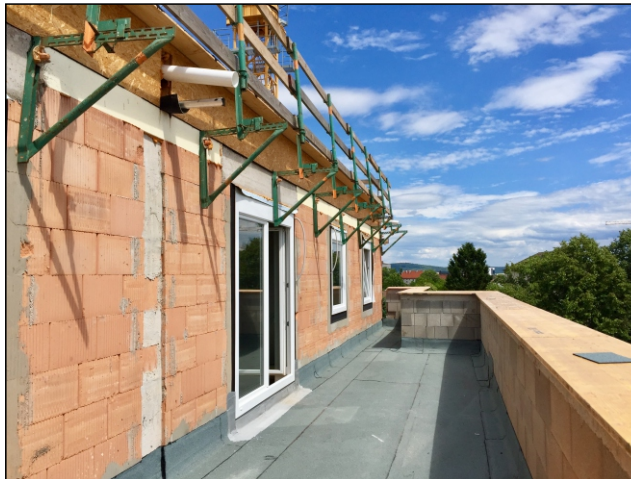
Haus 2, Top 14 Dachterrasse -Baustand Juli 2017
