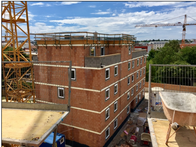
Haus 2 - Baustand Juli 2017
